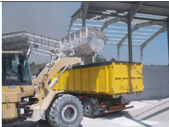
Figura 5 – Recolha de resíduos de betão no AH Daivões (21/08/2017)
